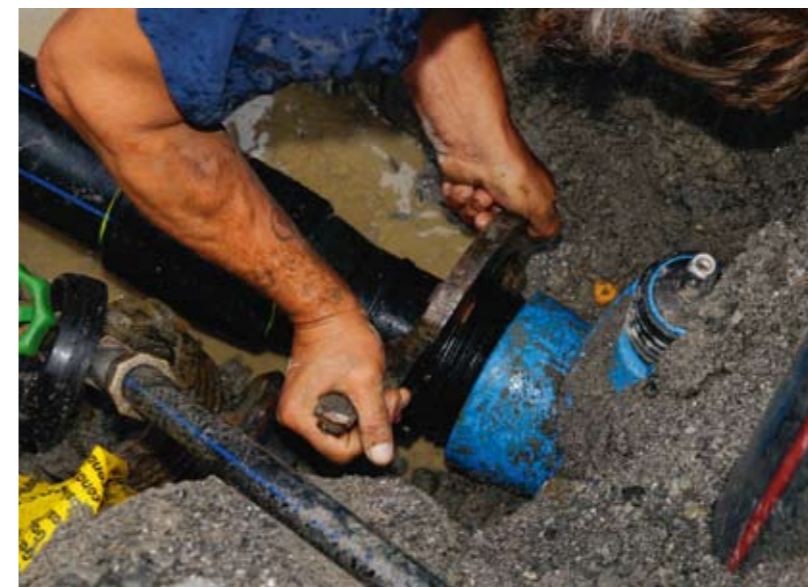
Montagearbeiten an einem Hausanschluss
